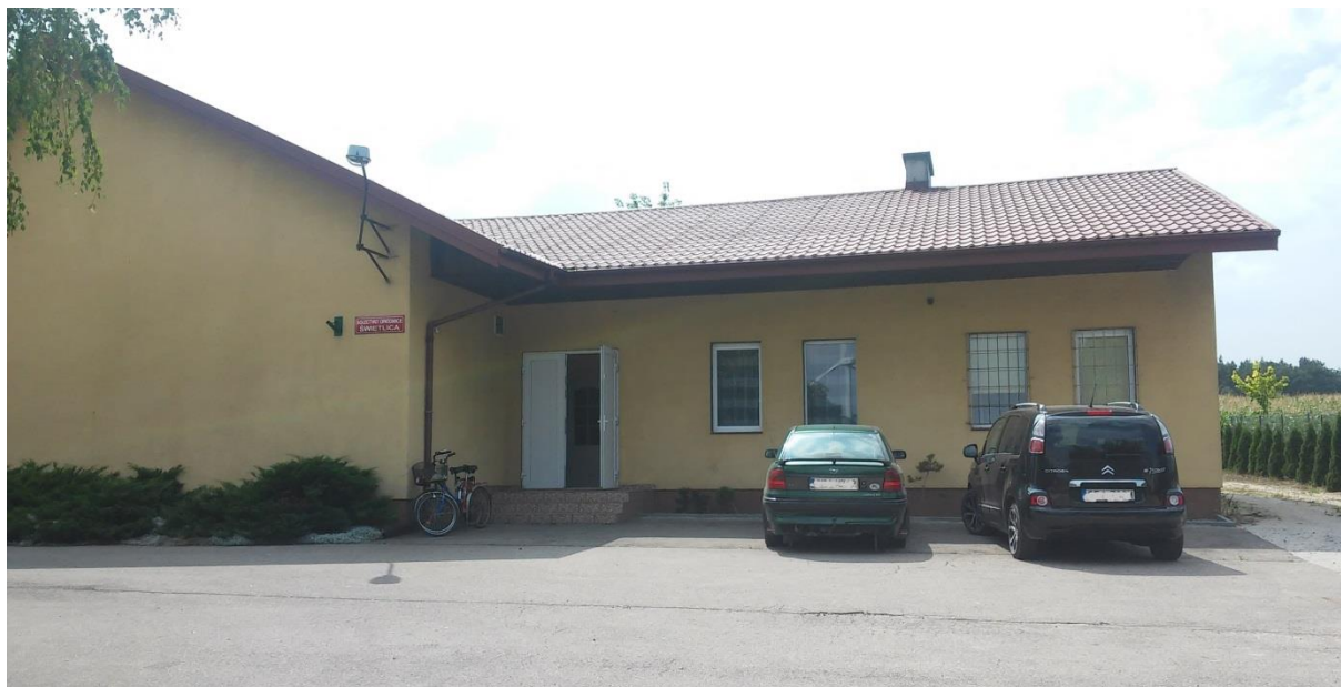
Zdjęcie 1. Świetlica wiejska w Opatowicach
