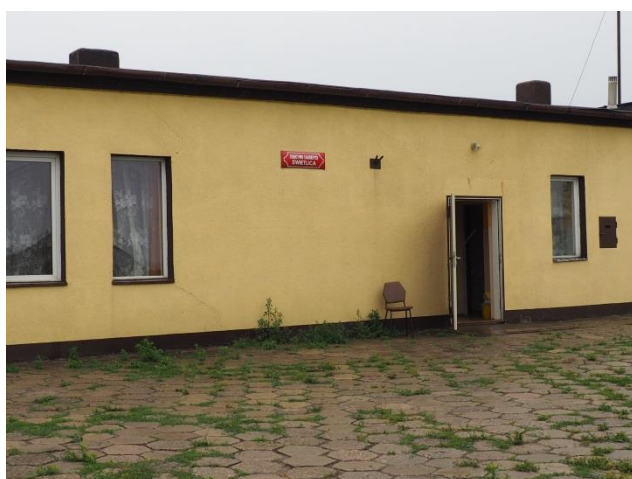
Zdjęcie 2. Świetlica wiejska w Zagorzycach
