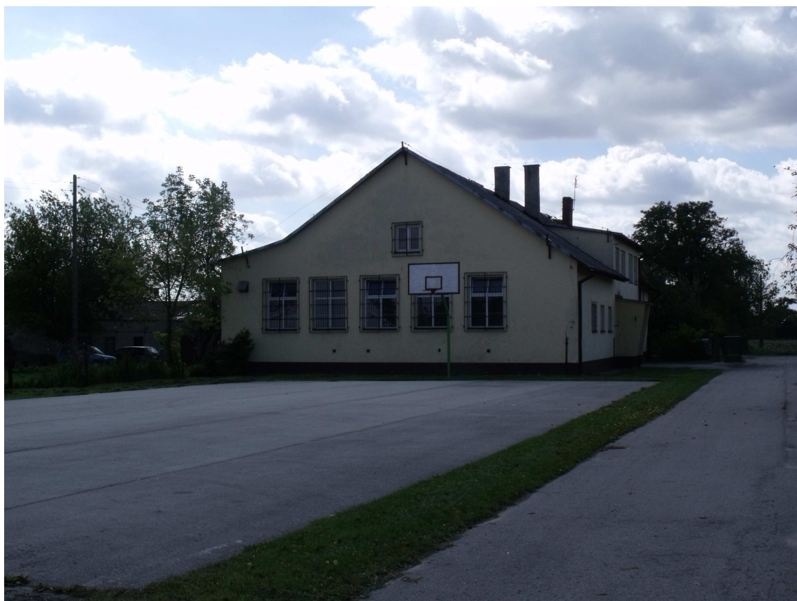
Budynek z salą gimnastyczną i boisko przy Gimnazjum
