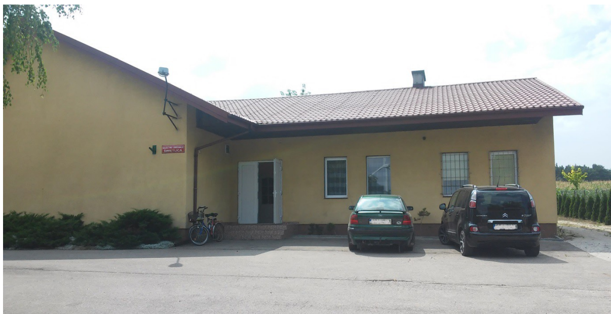
Zdjęcie 1. Świetlica wiejska w Opatowicach
